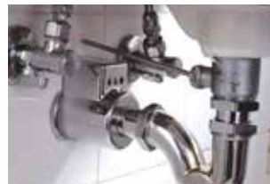
4) montaggio del sifone e
