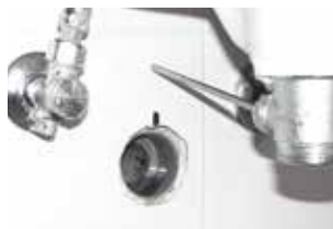
1) smontaggio del sifone esistente
