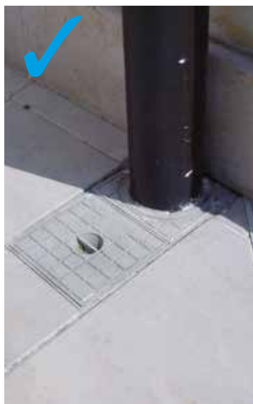
Pozzetto pluviale corretta installazione
