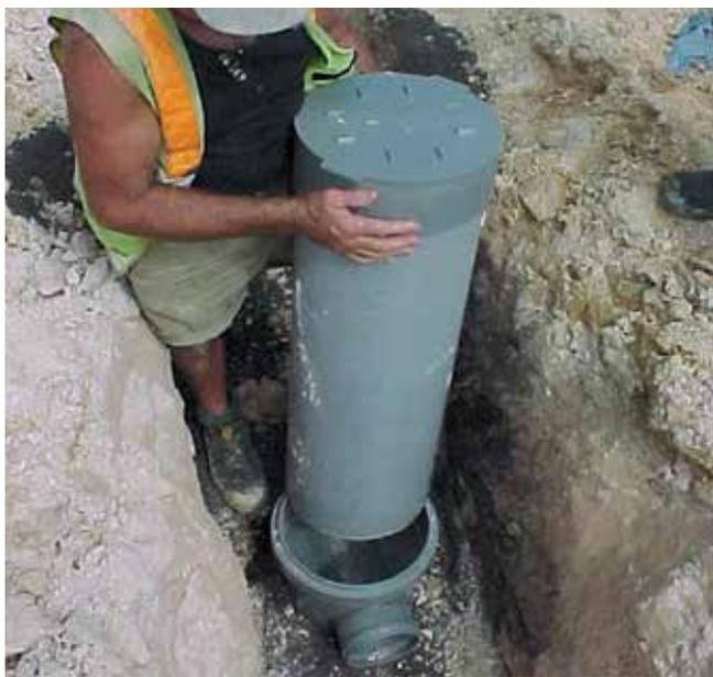
Esempio di installazione con pozzetti fognatura in PVC
