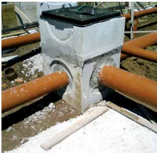
Esempio di installazione con pozzetti e prolunghie in cemento
