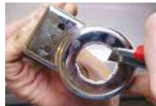
4) adattamento della rosetta cromata (d. 1"1/4 e 1"1/2 prefondato)
