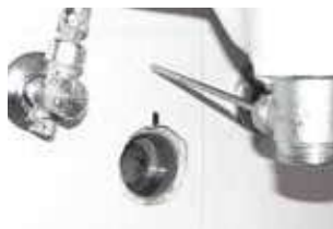
1) smontaggio del sifone esistente
