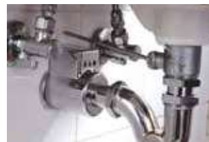
6) montaggio del sifone e armonia estetica finale
