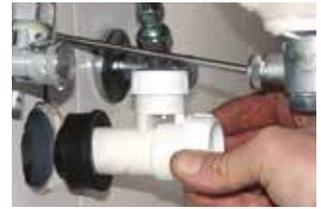
2) inserimento del corpo valvola con guarnizione tecnica montata
