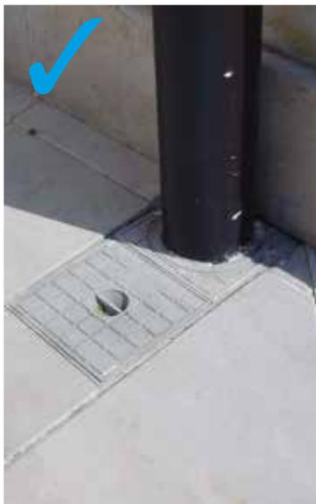
Pozzetto pluviale corretta installazione
