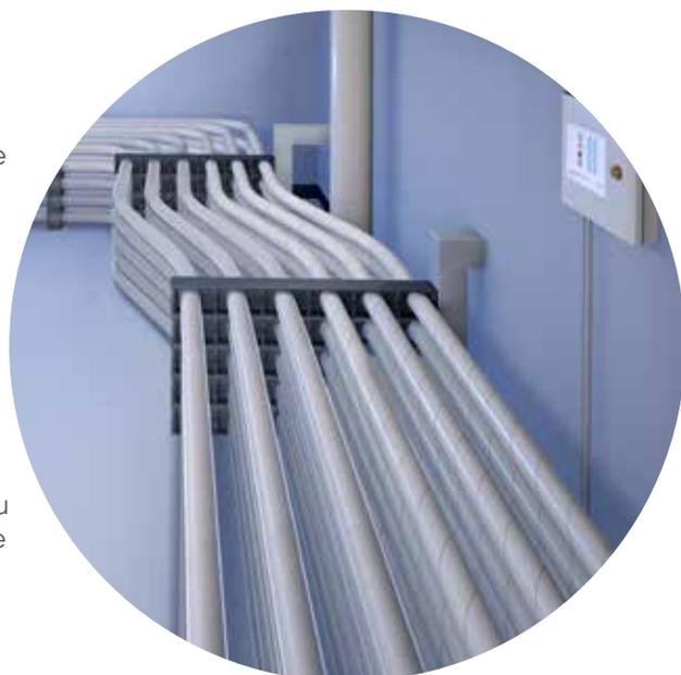
Prima di effettuare il collaudo, assicurarsi che il tubo flessibile si trovi a temperatura ambiente. Se è stato installato in condotti di cemento e simili ed è stato lasciato al sole, il tubo flessibile può trovarsi a una temperatura eccessiva per sostenere la prova in pressione senza causare una dilatazione eccessiva. Fare scorrere acqua nel tubo flessibile per un tempo sufficiente a consentire al tubo stesso di ritornare alla temperatura ambiente.
