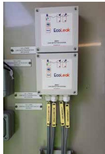
Aliaxis è in grado di offrire due tipi di monitoraggio delle perdite mediante cavi o sonde di rilevamento EcoLeak.
