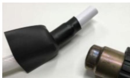
Riscaldare fino a quando il tubo termorestringente non si è ristretto completamente e la superficie risulta liscia. Continuare a muovere la fonte di calore per evitare fenomeni di carbonizzazione.
