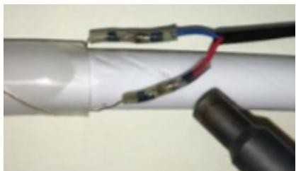
Riscaldare le guaine fino a quando non si sono ristrette completamente e gli anelli di saldatura non si sono fusi diventando fluidi. Continuare a muovere la fonte di calore per evitare fenomeni di carbonizzazione. Non muovere il collegamento fino a quando non si è raffreddato, poiché in caso contrario può indebolirsi.
