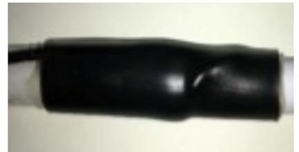
Riscaldare fino a quando il tubo termorestringente non si è ristretto e la superficie risulta liscia. Continuare a muovere la fonte di calore per evitare fenomeni di carbonizzazione. Ispezionare il collante esposto nel punto in cui il tubo termorestringente nero e il tubo interno si uniscono. Questa piccola goccia di adesivo esposto assicura la tenuta. Lasciare raffreddare l'intera area prima di maneggiare il tubo.
