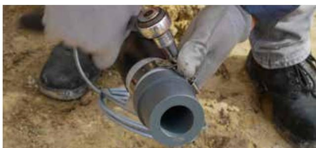
Le fascette stringitubo in acciaio inossidabile vengono utilizzate per bloccare il tubo interno del sistema ProtectaFlex Detect allo scopo di realizzare la giunzione con raccordi in plastica o, eventualmente, di bloccare il tubo esterno della soluzione.
