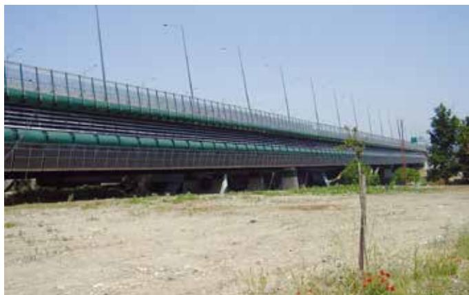
Realizzazione della rete di drenaggio del manto stradale. L'opera riguarda la costruzione della terza corsia dell'Autostrada del Grande Raccordo Anulare di Roma. Mediante la realizzazione di due ponti in acciaio che servono le due carreggiate. Tali ponti si sviluppano su una lunghezza totale di circa 360 metri con luce libera centrale di 160 metri.
