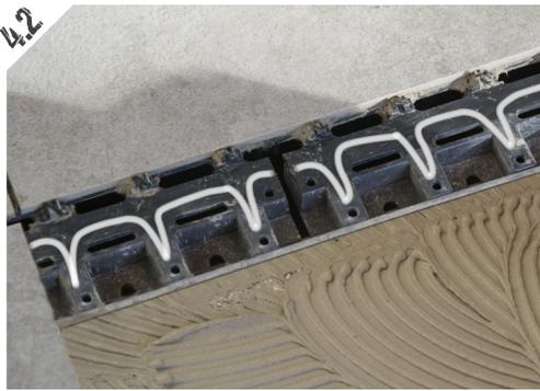
La parte di rivestimento che si estende sulla soletta in calcestruzzo o sul massetto viene fissata in modo convenzionale utilizzando una malta adesiva.
