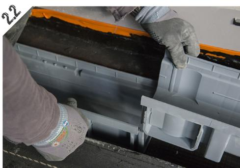
Assemblare il corpo delle canalette sulla soletta in calcestruzzo tenendo conto dell'attacco maschio/femmina.
