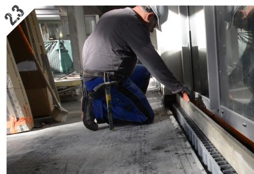
Per mantenere la giusta distanza e garantire uno spazio di dilatazione, in fase di fissaggio del corpo della canaletta prevedere un distanziale di 129 mm di larghezza o installare una griglia con uno spessore per garantire la tolleranza di assemblaggio.
