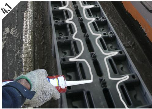
Applicare uno strato di mastice\* sulle zone piene del lato superiore della griglia. La quantità di mastice applicato deve essere sufficiente a garantire l'adesione del rivestimento. Fare attenzione che il mastice non ostruisca le aperture centrali.
